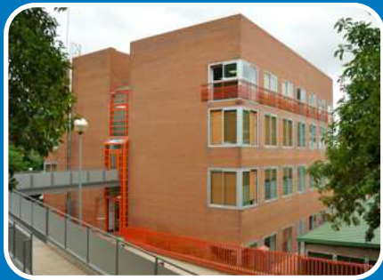
Recuperació i remodelació de l'edifici del Cub (Batxillerat) a Esplugues
