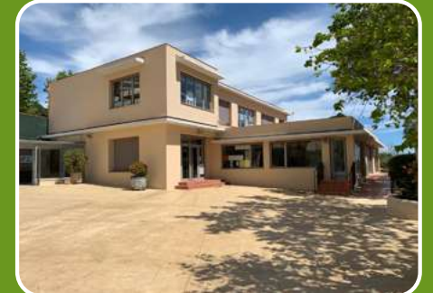
Remodelació de l'edifici Somnis (infantil) a Badalona
